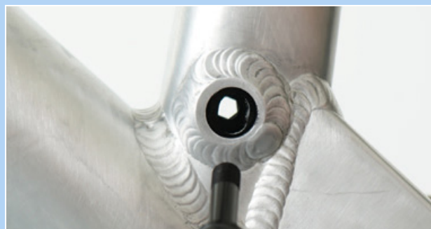
Obr. 216: Otvor v rozhraní Postpin
